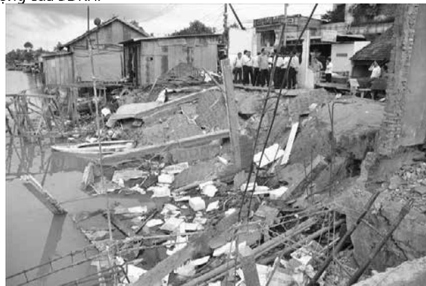
Hình ảnh những căn nhà bị sập xuống dòng sông ở khu vực ĐBSCL
