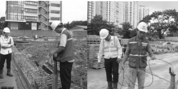
Hình 4. Thiết bị Inclinometer và lắp đặt đo chuyển vị ngang của tường vây
