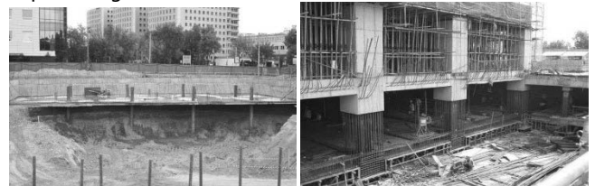
Hình 1. Thi công tầng hầm nhà cao tầng bằng công nghệ Top-Down [3, 4]
