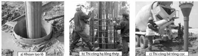
Hình 2. Móng cọc khoan nhồi bê tông cốt thép [4]
