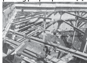
a) Hệ văng chống, thi công Bottom Up
