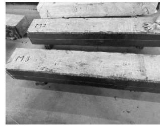
Hình 6. Gia cường tấm CFRP lên bề mặt dầm
